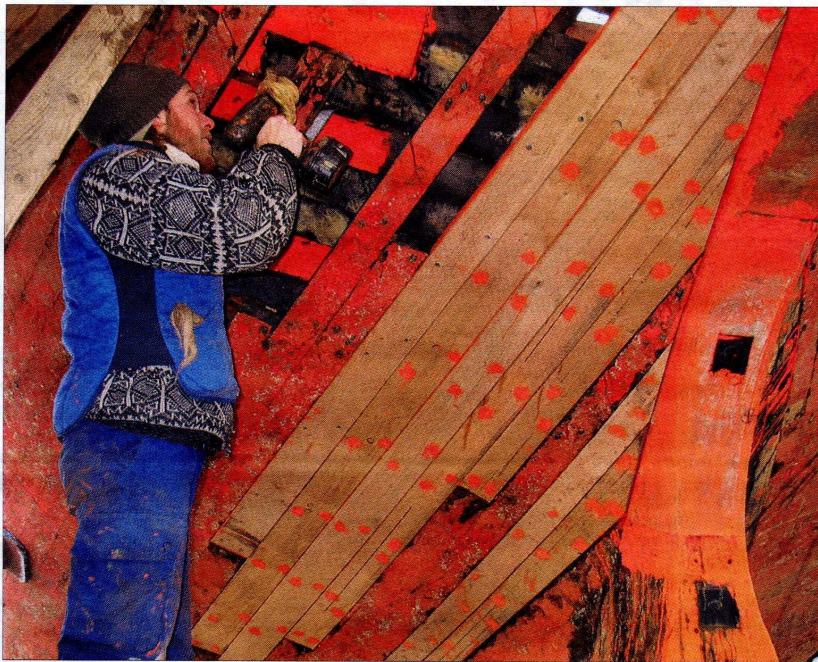
Lourds travaux de charpente sur l'arrière du « Manuel-Joël ». PHOTO PHILIPPE BAROUX
