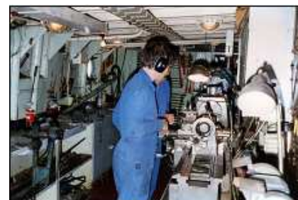
Atelier de la salle des machines
